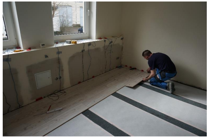
Verlegung eines frei wählbaren Bodenbelags
