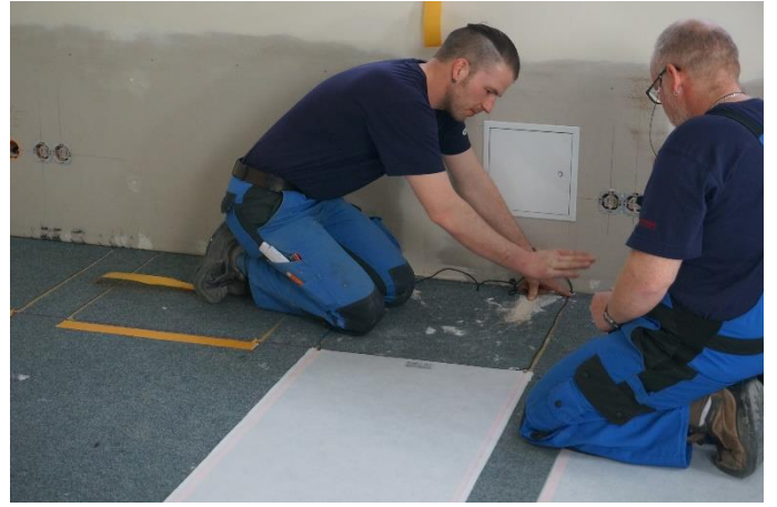
Verlegen der Infrarot-Carbon-Heizbahnen
