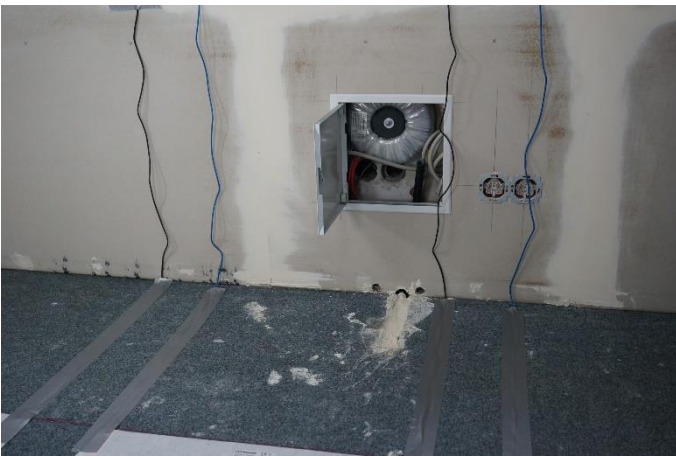
Anschlußleitungen für Bodeheizung
