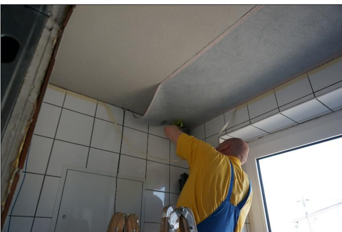
Aufkleben der Infrarotbahnen an der Decke
